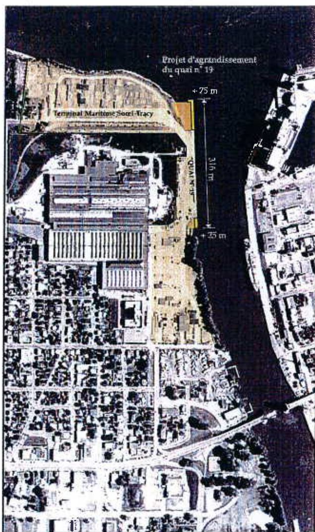
Aggrandissement de 100 m du quai n° 19
